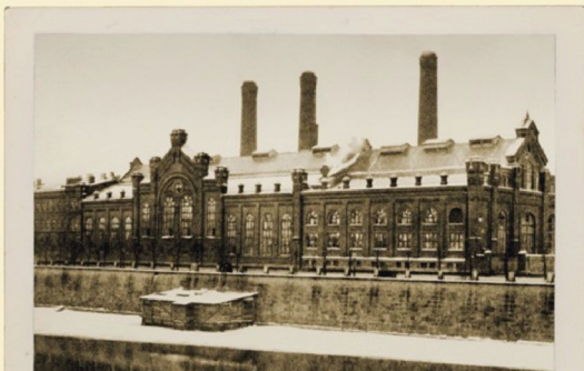
Центральная электрическая станция на Раушской набережной. 1910 г.
