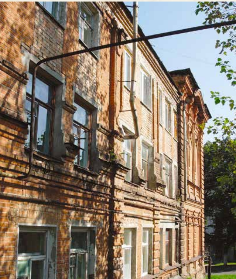
Здание ГубЧК на улице Красной в Пензе
