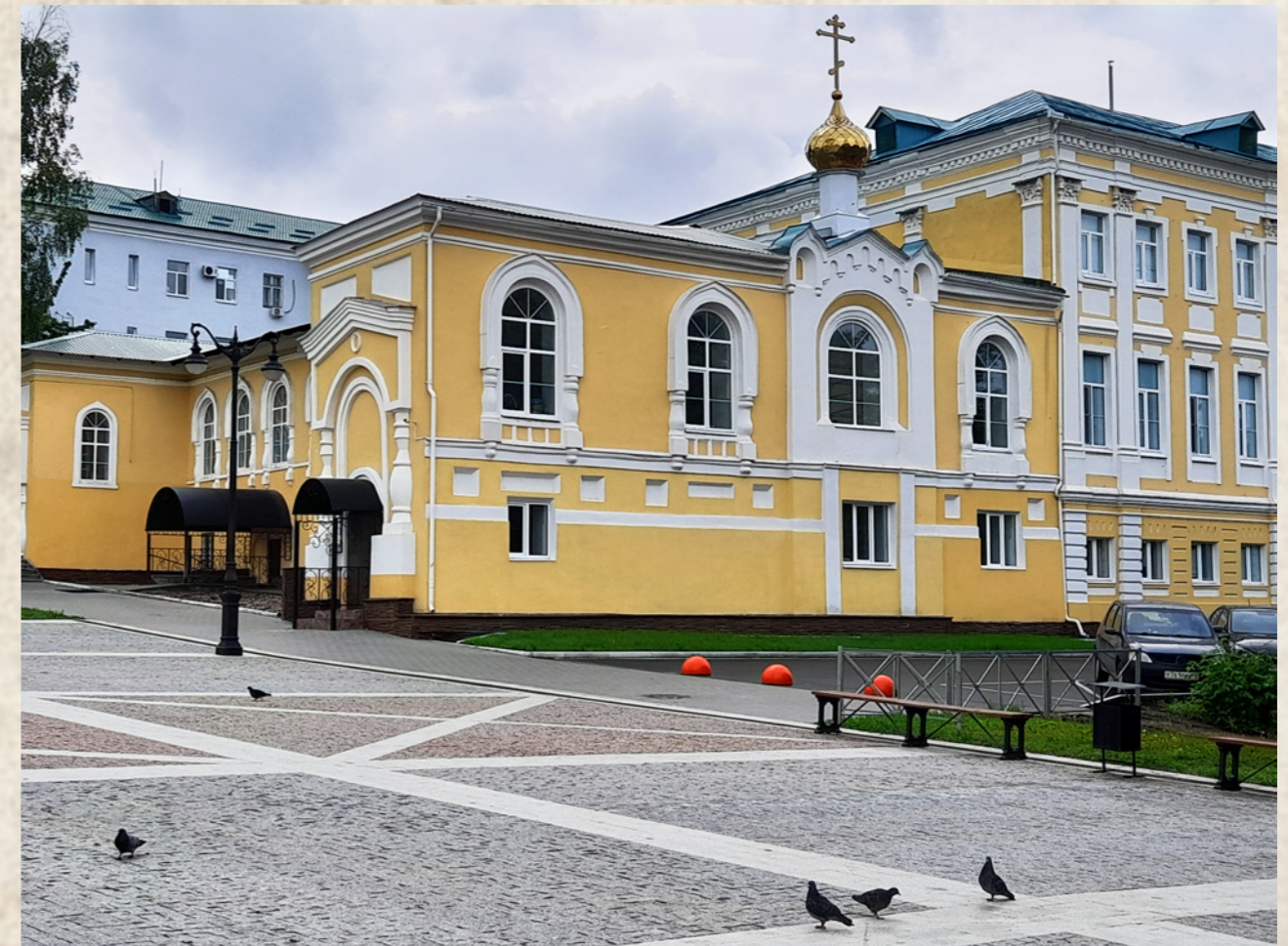
Воскресенская церковь при архиерейском доме. 2023 г. Фото автора
