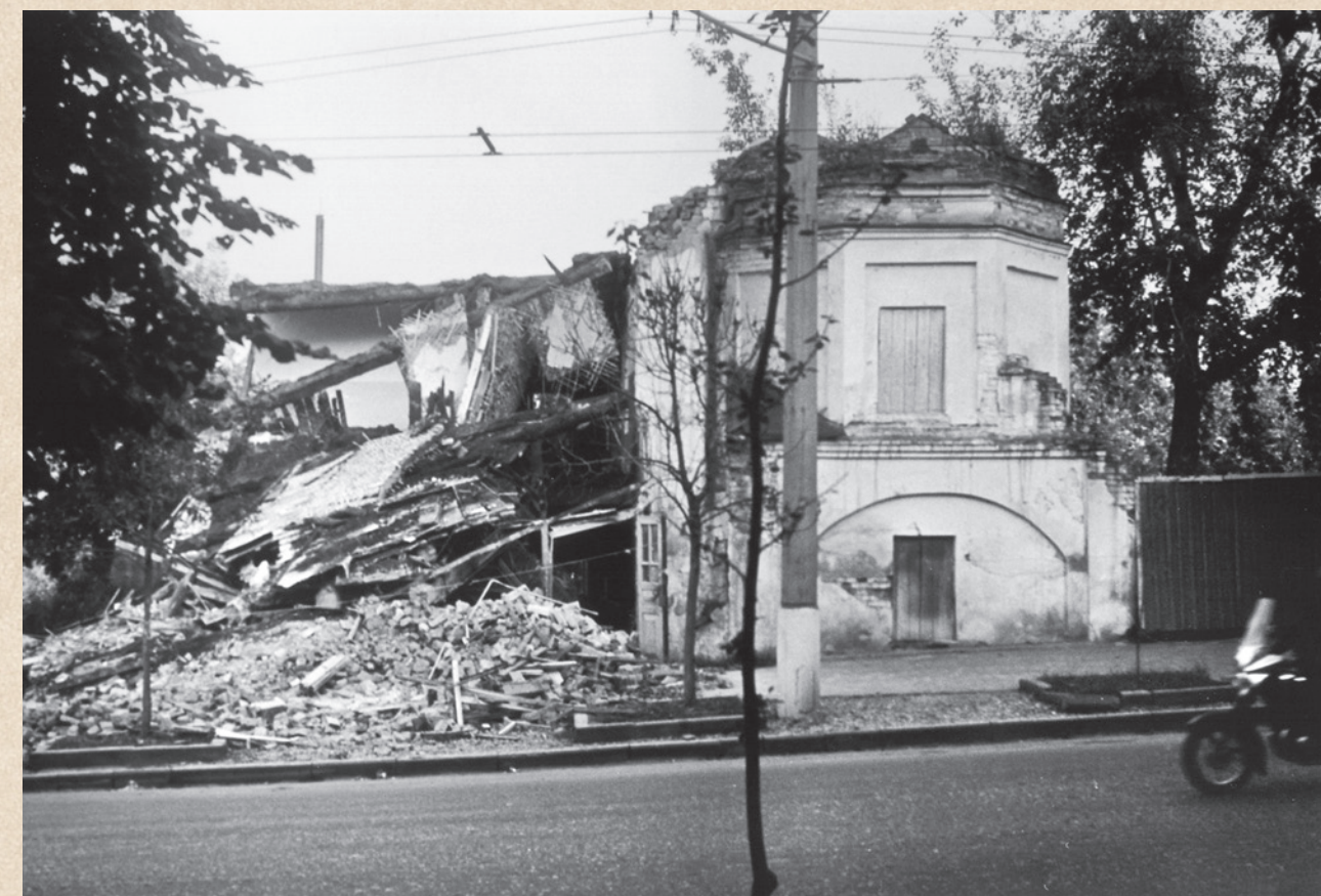
Разрушенный дом Урановых (ул. Кирова, 29). Справа башня монастырской ограды
